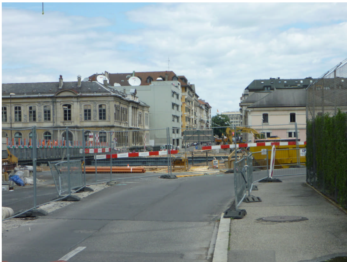
14. Perspective sur la passerelle Wilsdorf (en travaux) et la rue de l'Ecole-de-Médecine
