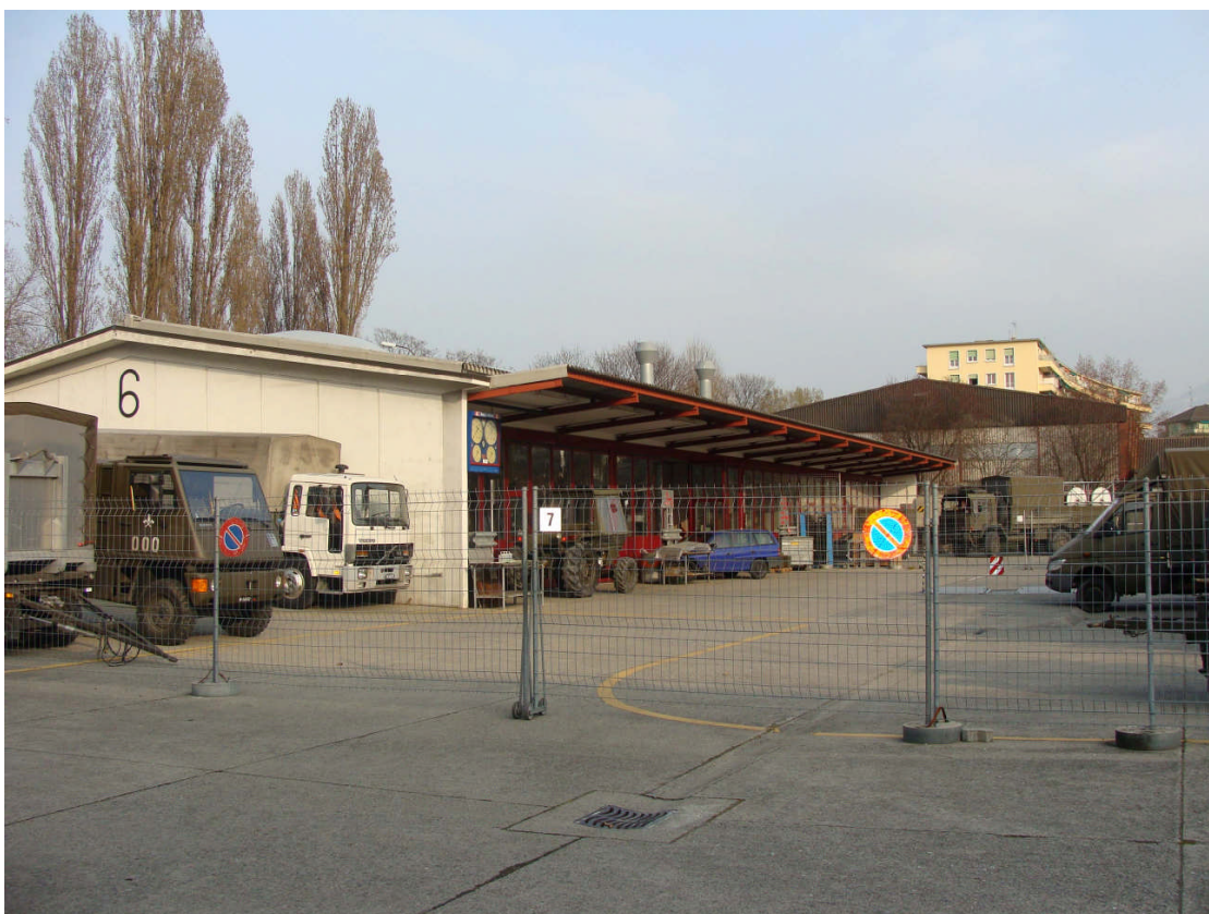
6. Bâtiment D, bâtiment F au second plan
